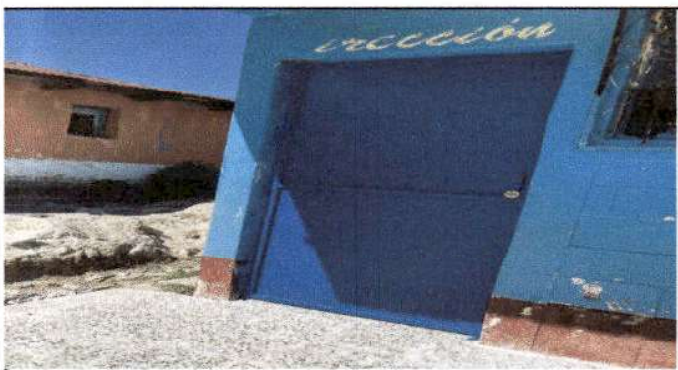
Foto 3: Finalizacion de fabricación e instalación de puerta de metal (Módulo No. I)
