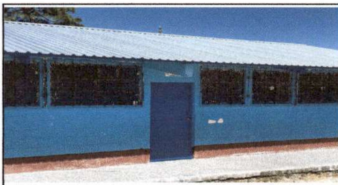
Foto 4: Finalización de fabricación e instalación de puerta de metal (Módulo No. II)
