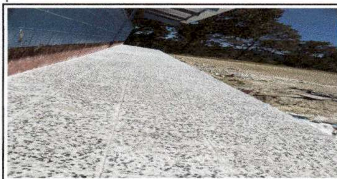
Foto 6: Finalización de sustitución de piso torta por piso granito (Corredor)
