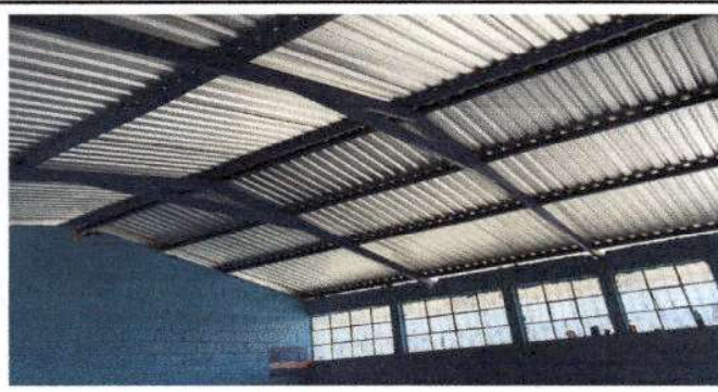
Foto 2: Finalización des sustitución de estructura de soporte de madera por metal.
