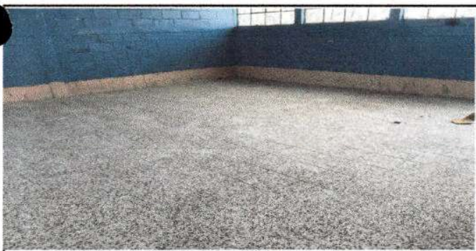
Foto 5: Finalización de sustitución de piso torta por piso granito (Aulas)
